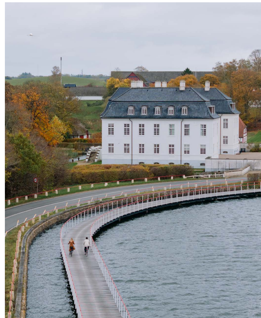
200 meter dobbeltrettet cykelbro ved Hvidkilde Gods på Sydfyn.
